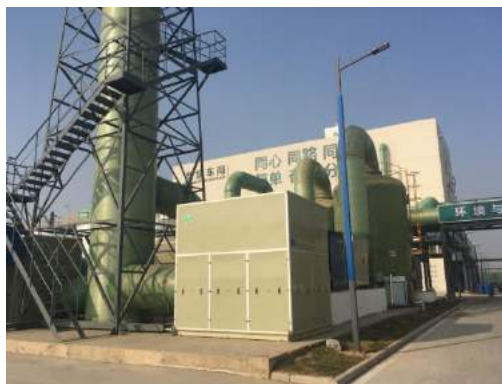
暂存库及料坑除臭区
