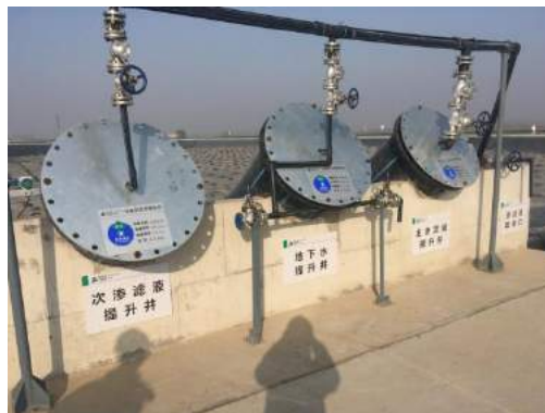
填埋场提升井
