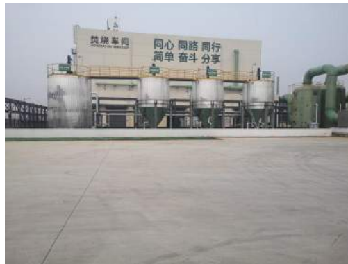
待检区及焚烧废液罐区
