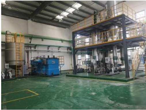
含油废物处理区
