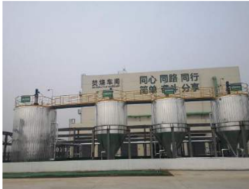
焚烧废液罐区围堰
