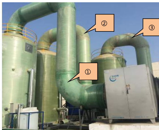
暂存系统处理 3 套装置
