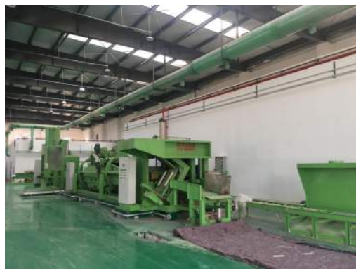
资源化车间防渗
