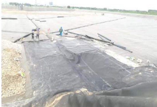
填埋场土工膜铺设
