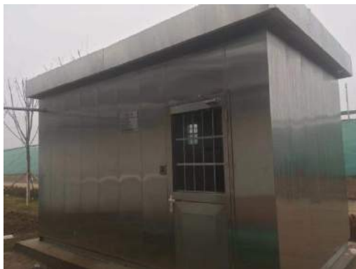
废水监测小屋
