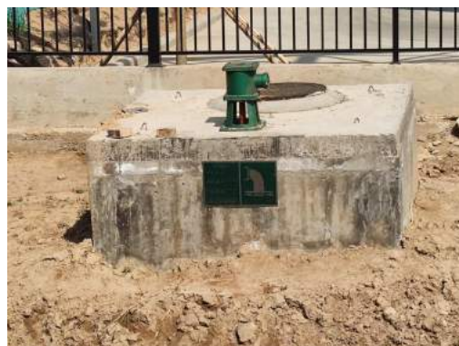
厂区雨水排口 1
