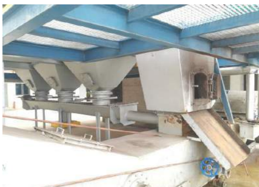
焚烧残渣出渣
