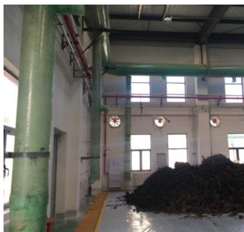
资源化车间废气收集管道
