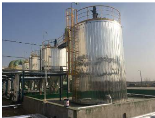
焚烧废液罐区围堰
