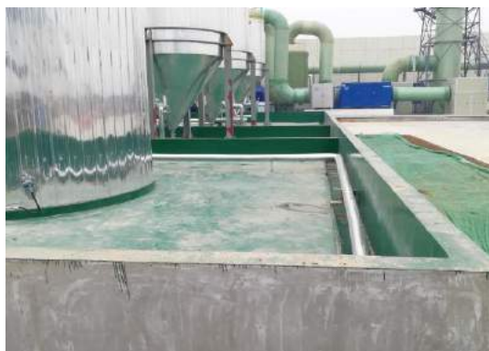
焚烧废液罐区围堰
