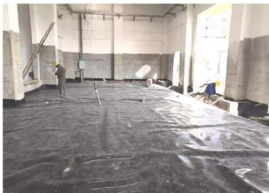
卸料大厅 HDPE 膜
