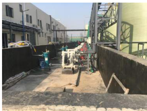
物化废液罐区防火堤
