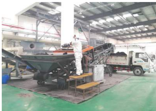
固化/稳定化车间防渗
