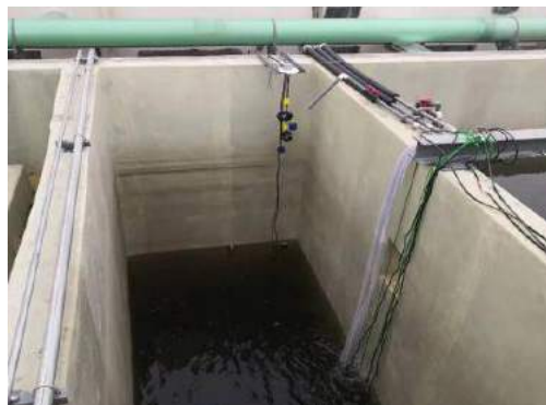
污水处理站出水池
