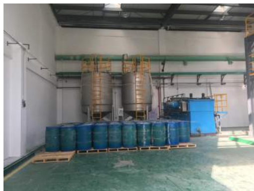
物化车间防渗
