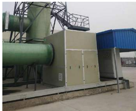
风机减震基础+隔声罩
