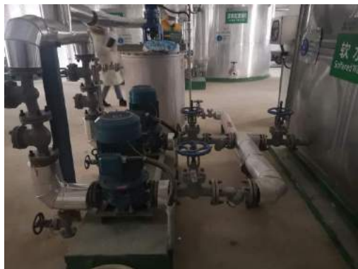
泵减震台+室内布置
